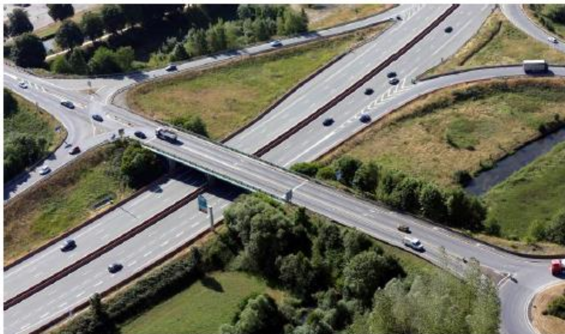
La construction de l'échangeur A36/RN 1019 suscite des craintes chez les riverains. Photo d'archives
